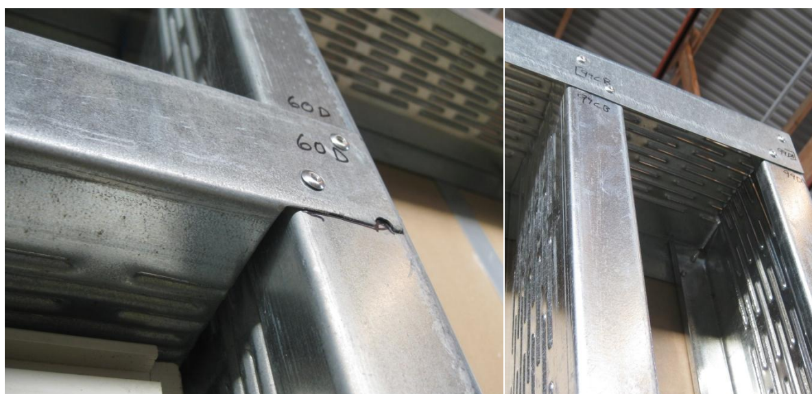
Figur 31. En prototypvägg ritad i Opticon, levererad förstansad och monterad med blindnit.
