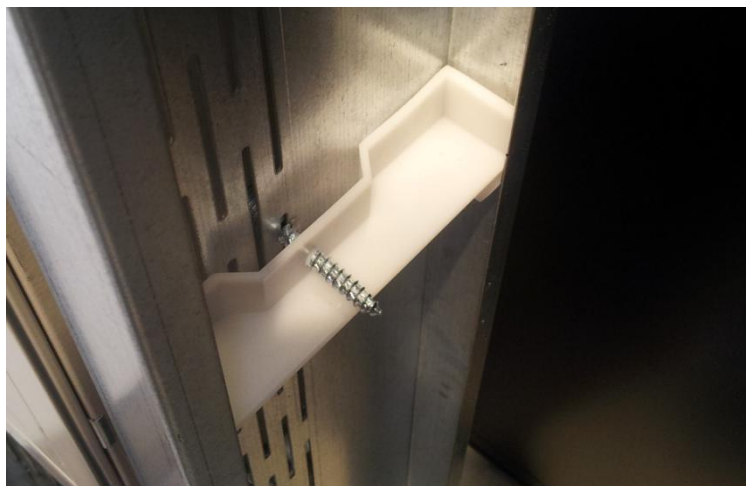
Figur 26. Lindabs fönsterbeslag som ska styva upp regeln i infästningspunkten
