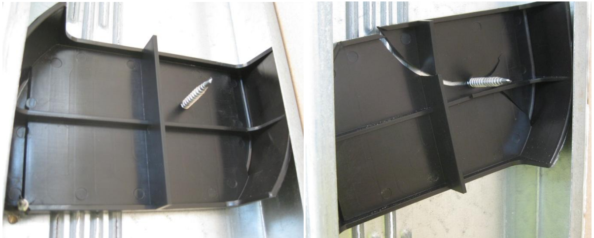
Figur 27. Cirka 50 % av fönsterbeslagen sprack vid montage (montagetemperatur ca: 1°C).
