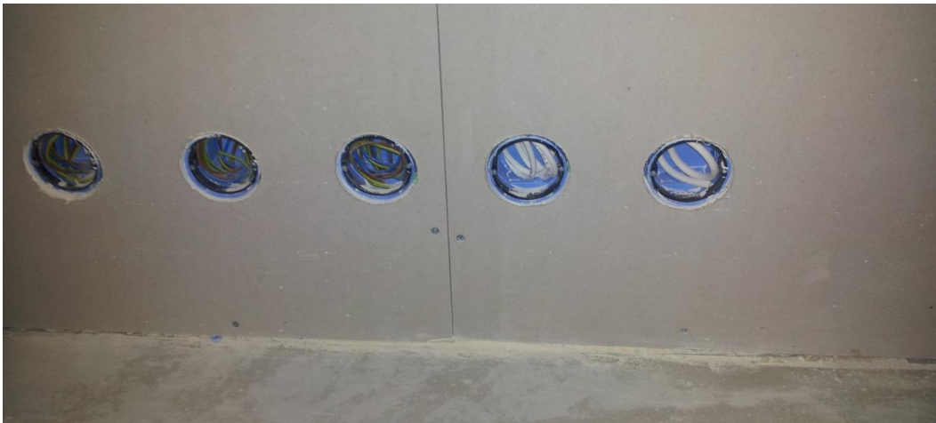
Figur 23. Eldosor som inte kan regleras i djupled kan vara problematiskt vid limning i profiler eftersom skivan då behöver skjutas på plats. Rätt eldosor underlättar således.
