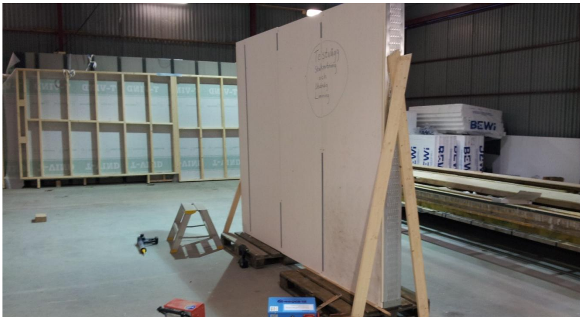
Figur 20. Provvägg nr 1 för stuknitning och utvändigt limning byggdes stående vid 2°C.
