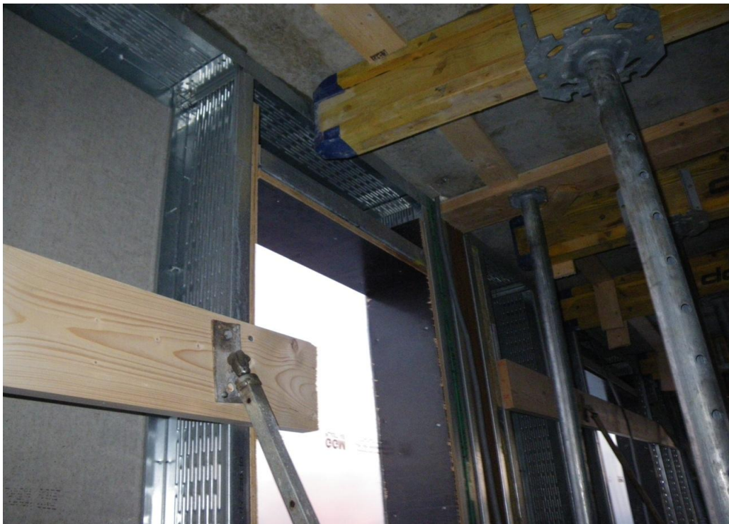
Figur 1. Formplywood används ofta runt fönster för att styva upp reglarnas liv.
