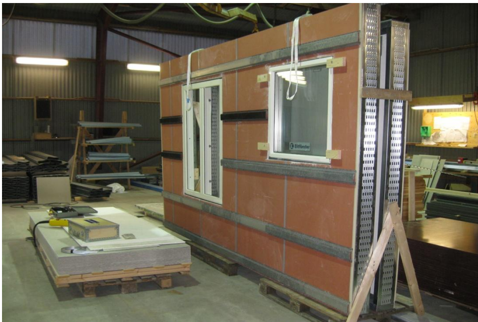
Figur 22. Den ventilerade fasadläkten monterades innan väggen lyftes från bänken.
